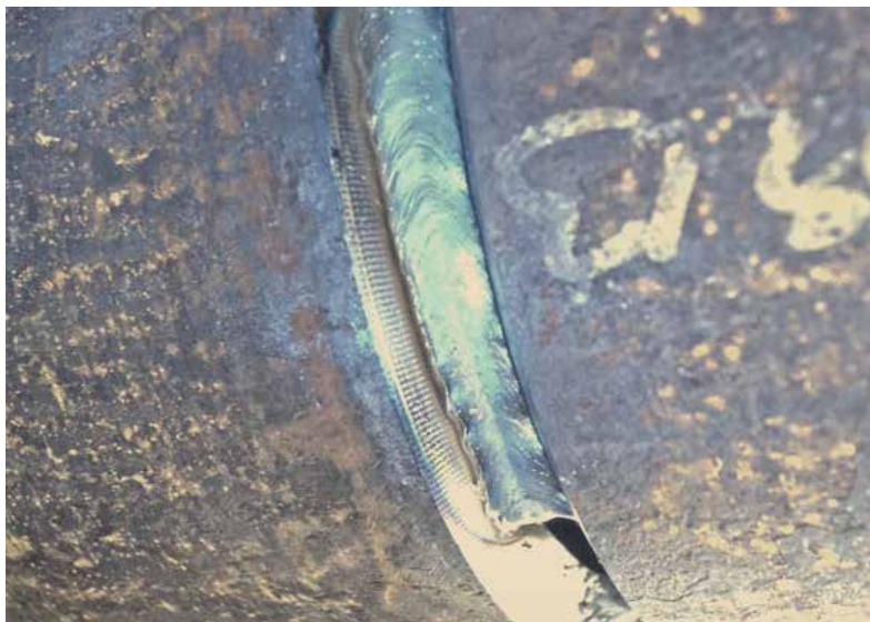
IAC - Вертикальный шов "сверху - вниз" при соединении труб значительно увеличивает скорость сварки по сравнению с традиционным способом "снизу-вверх"
